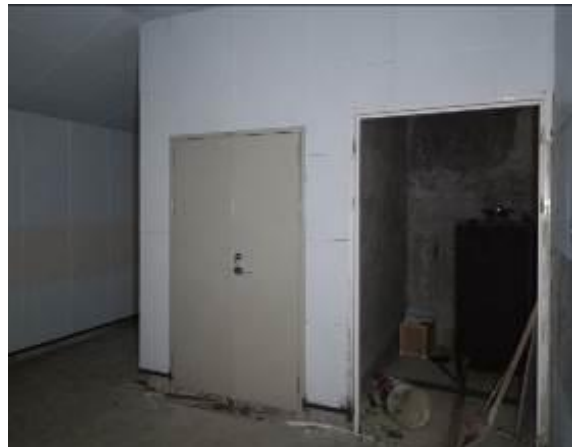
发电机水喷淋设施
