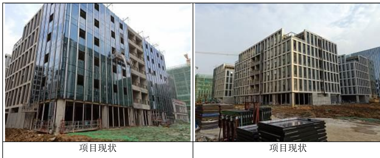
图 3.3-2 建设项目及周边情况照片
