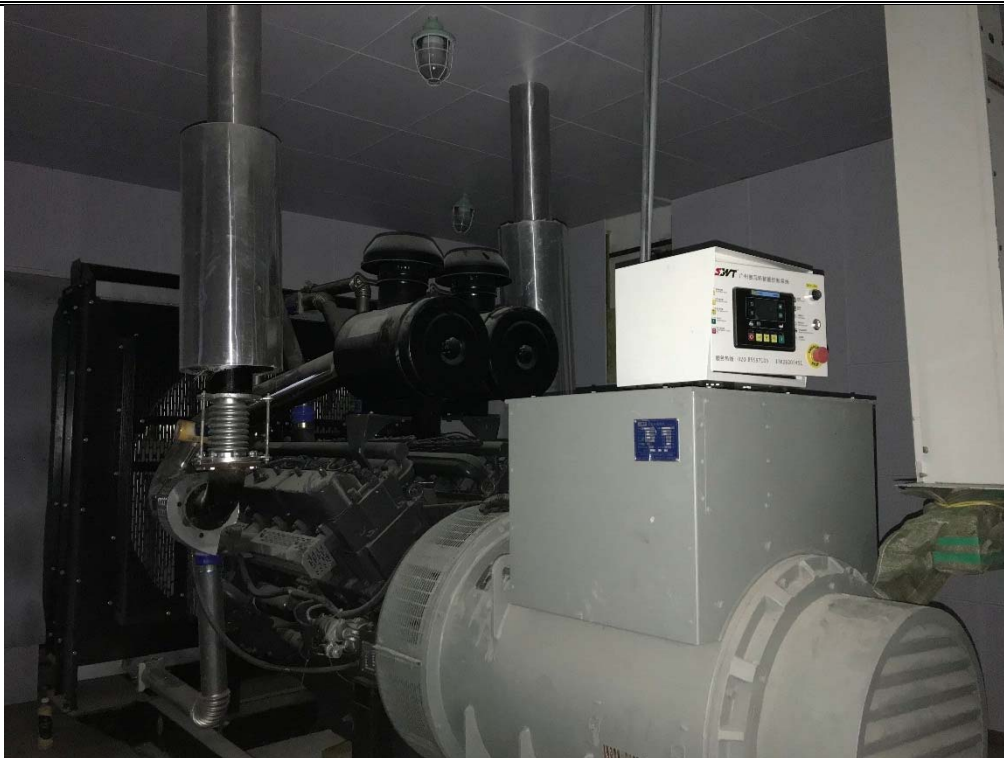
2号发电机及隔声墙
